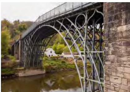
▲ 鑄鐵：鐵與碳組成的合金，因其成本低廉而廣泛用作結構材料
