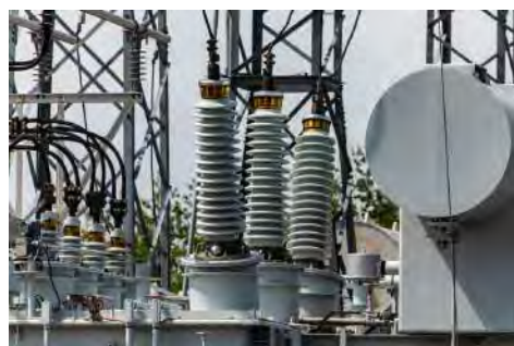
▲ 氧化鋁陶瓷是其中一個先進陶瓷的例子，常用於作為固定高壓電線的絕緣體。
